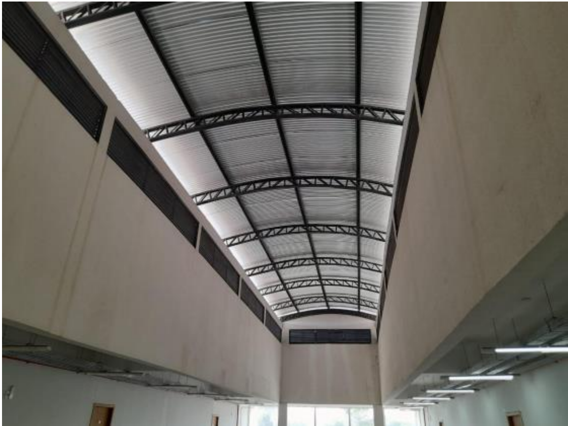
Imagem 02 – Local onde estão instaladas as telhas metálicas galvalume 0,43 mm.
